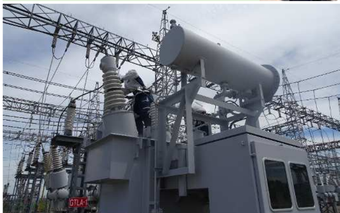
66kV 真空遮断器(VCB)点検
