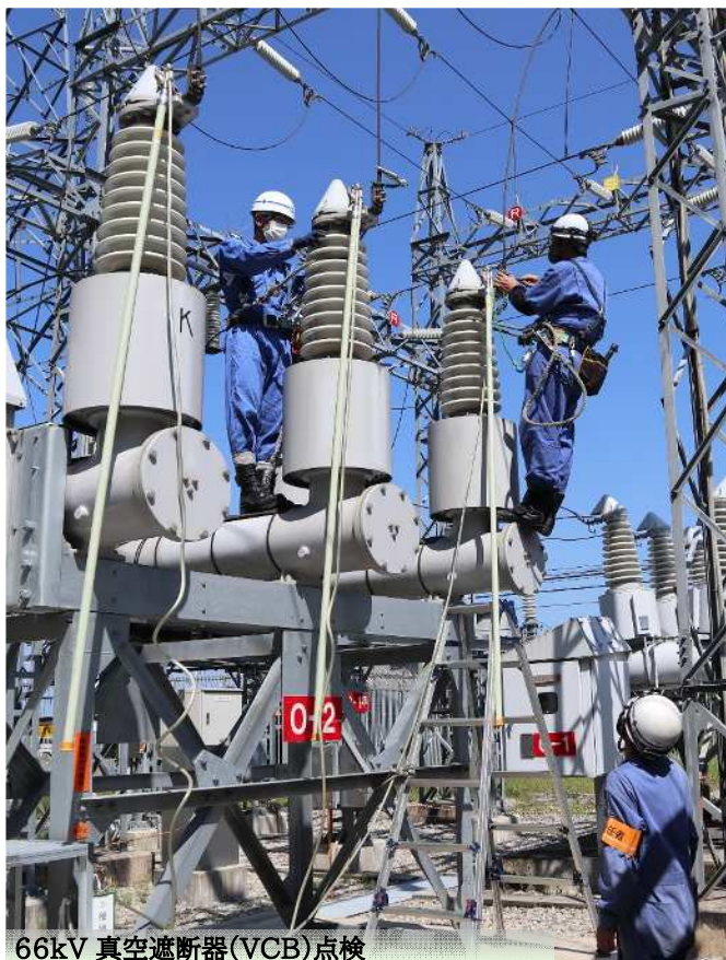
66kV 断路器(LS)点検
