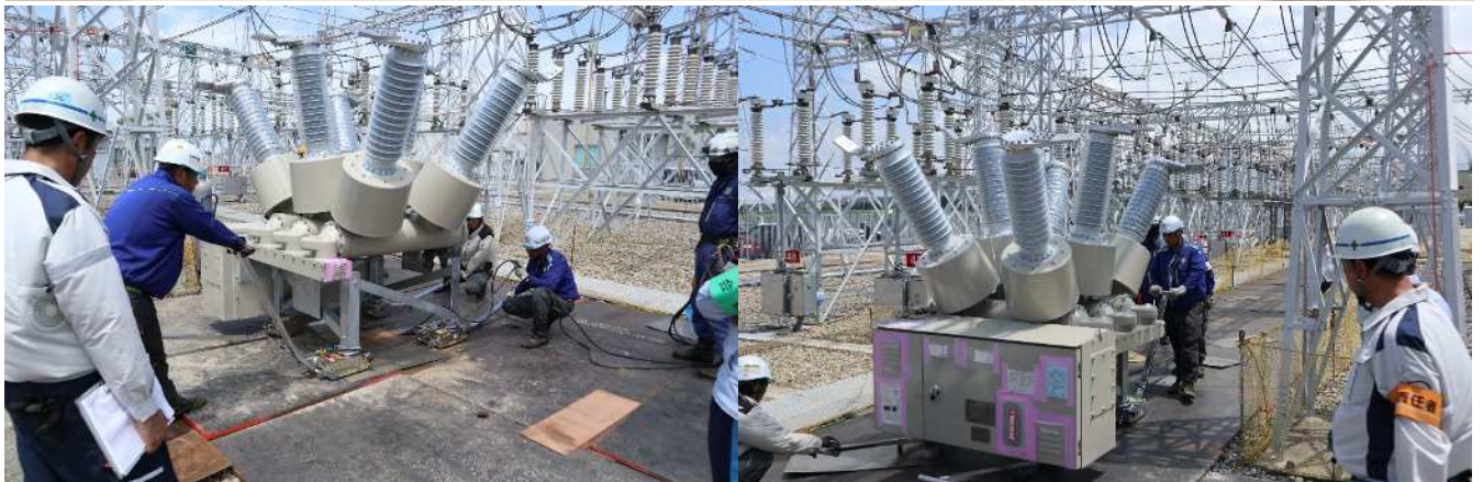
66kV 変圧器(Tr)据付調整工事
