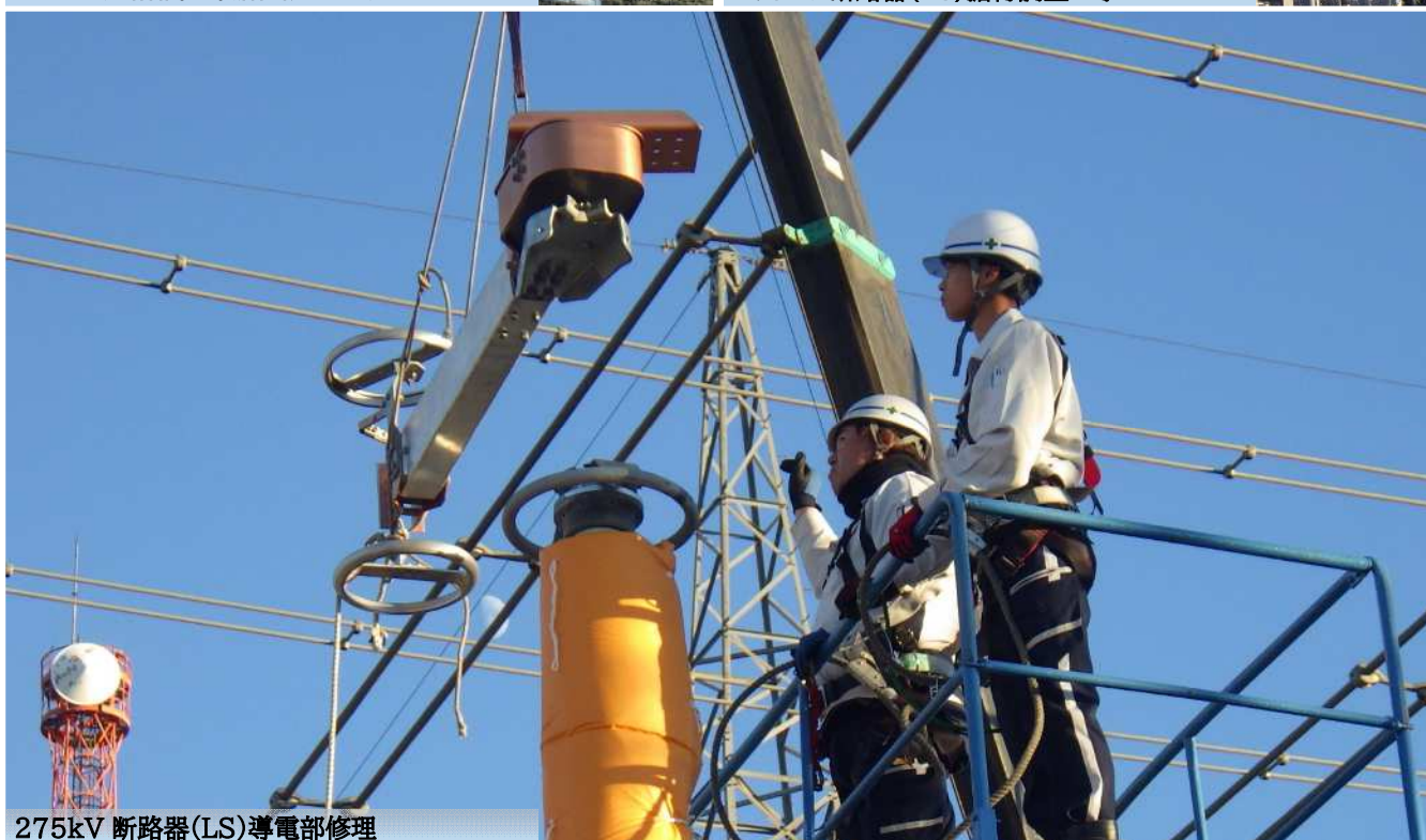
66kV 断路器(LS)据付調整工事
