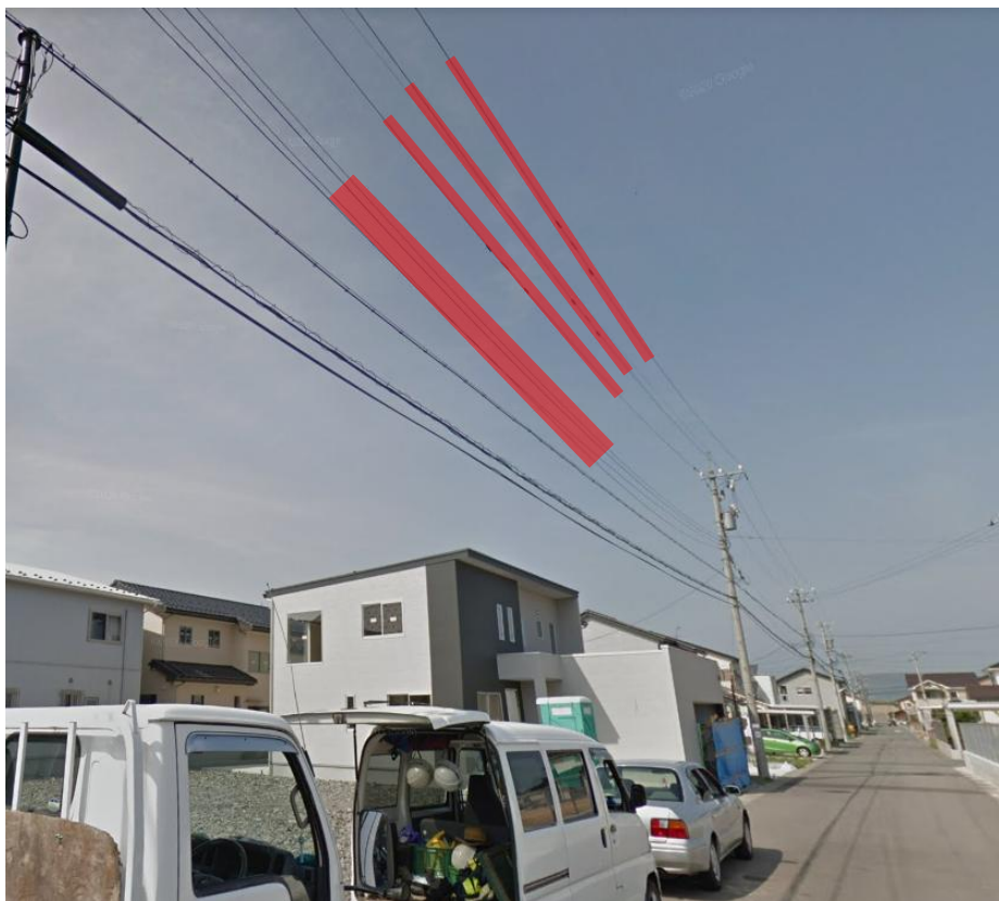
現地写真_記載例① 建物建築等クレーン使用時
