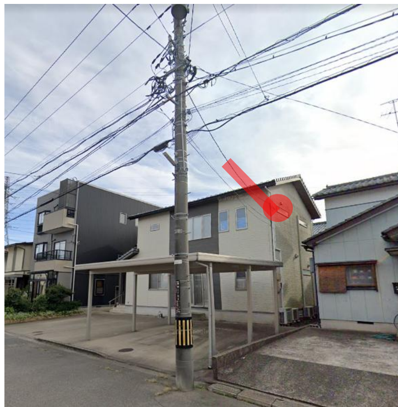
現地写真_記載例② 外壁改修等の足場設置時
