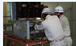
遮断器分解点検
